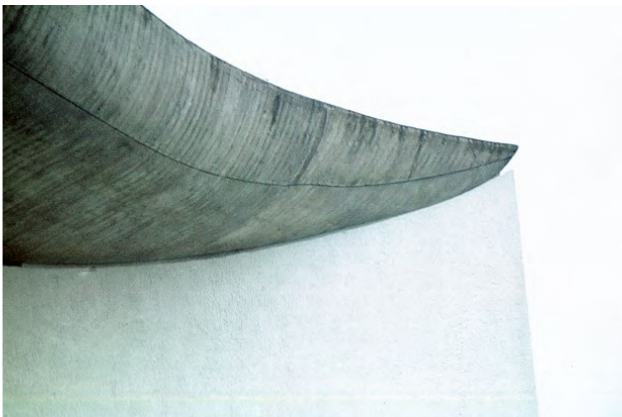
Il. 163. Dach jest zwieszoną ponad wnętrzem kaplicy skrzynią z cienkich, zbrojonych powłok betonowych
