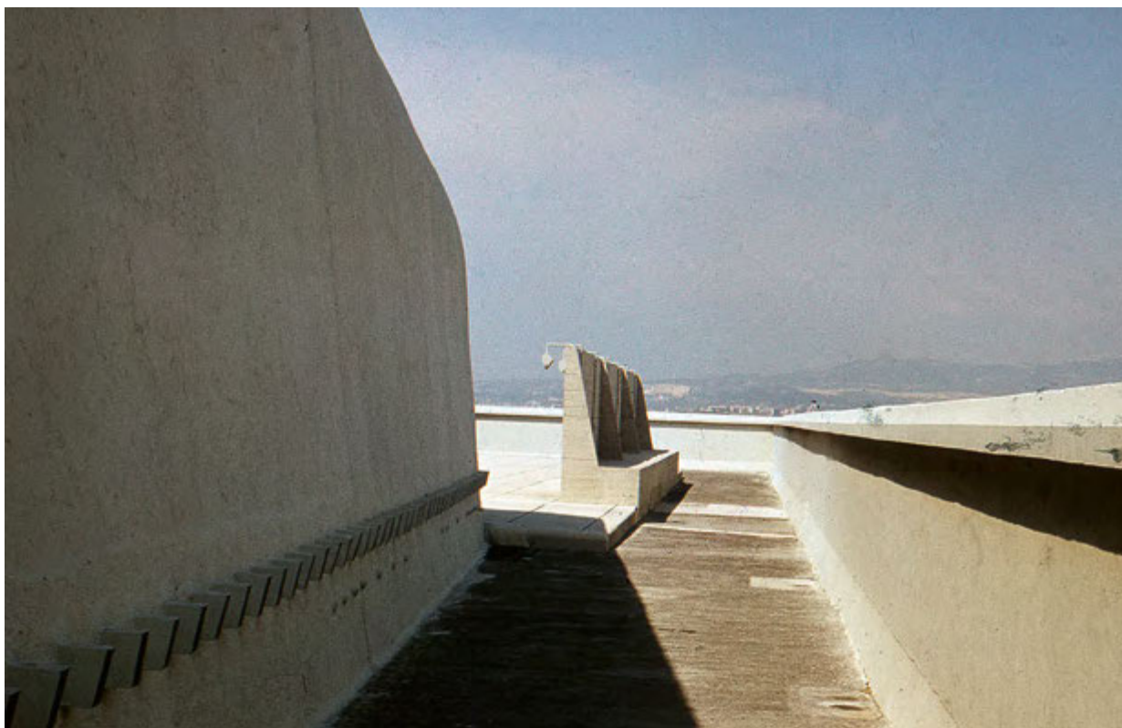
Il. 104. Bieżnia wokół dachu-tarasu Domu w Marsylii
