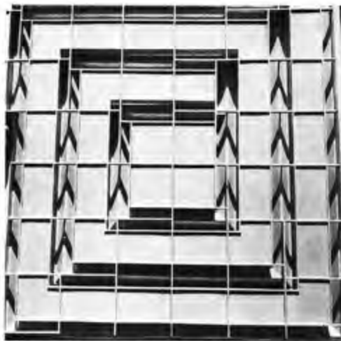
Plafond du musée vu de dessous. On voit le dispositif rigoureusement rationnel de la lumière de jour et de nuit. The ceiling of the museum as seen from below, showing the extremely rational arrangement for both day- and night-time illumination. Die Decke von unten gesehen. Rationelle Anordnung der Tages- und Nachtbeleuchtung.
