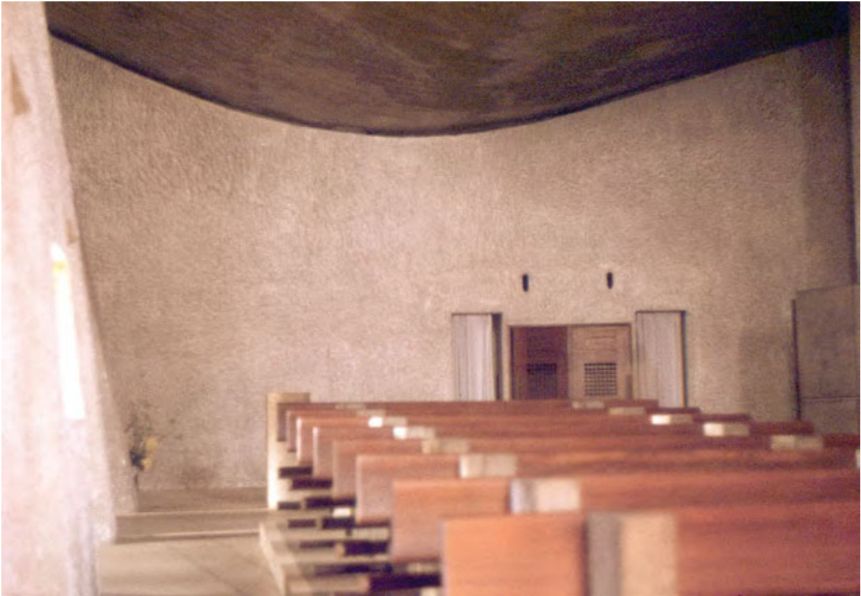
Il. 164. Dach jest zwieszoną ponad wnętrzem kaplicy skrzynią z cienkich, zbrojonych powłok betonowych
