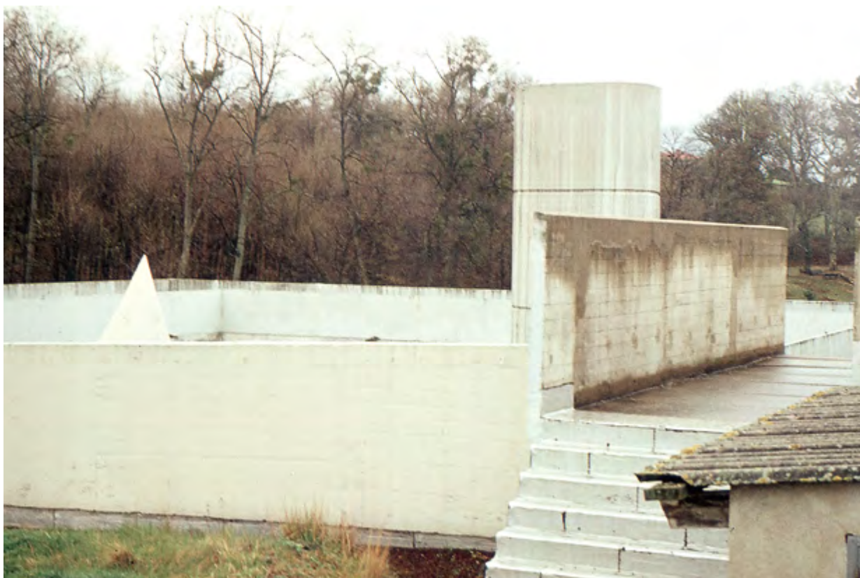
Il. 173. Dach – taras, czyli zielona łąka na dachu
