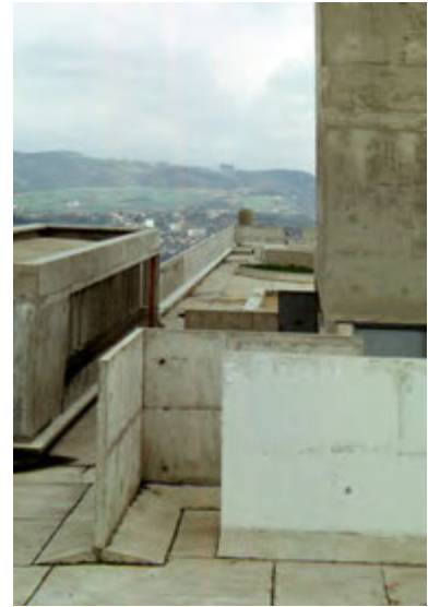
Il. 139. Surowy Dach taras Domu w Firminy
