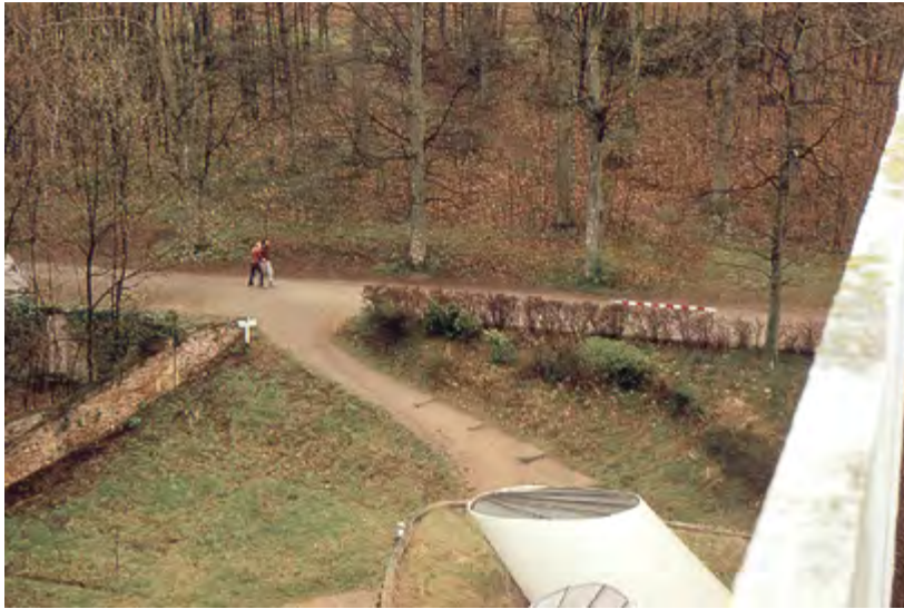
Il. 175. Widoczne rury doprowadzające światło do kościoła
