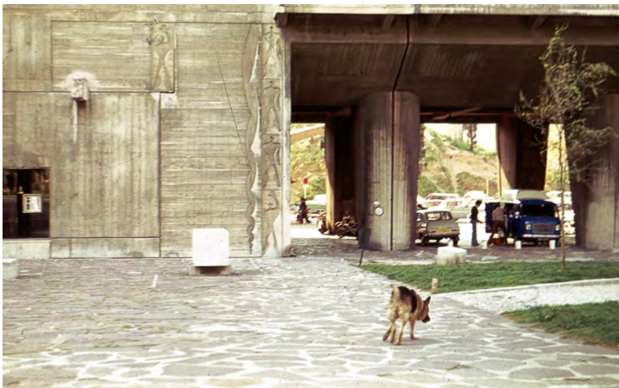
Il. 84, 85. Pale ( pilotis ), na których posadowiony jest Dom w Marsylii
