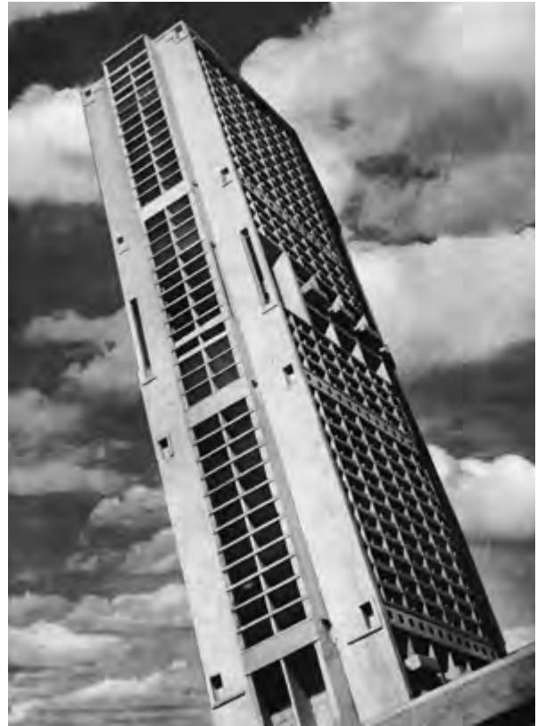
Il. 83. Ostatni projekt, z 1942 roku, dla Algieru. Quartier de la Marine . Drapacz chmur. Brises-soleil nie są tu loggiami, ale konstrukcją umieszczoną przed elewacją, tak aby dawała stosowny cień
