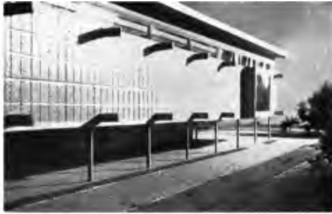
Aspect d'une des façades provisoires du musée, destinée à devenir une paroi intérieure: on voit apparaître les poutres standards sur lesquelles s'accrocheront les nouvelles constructions. View of one of the temporary facades of the museum, eventually to become an interior partition: one can see the standardized columns which will support the future enlargement of the museum. Ein für provisorischen Fassaden des Museums, die dann bei fortschreitender Erweiterung zu einer Innenwand wird.
